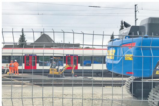
Ab sofort wird der Bahnhof zur Baustelle. Gestartet wird mit der Sanierung des Gleis 1 sowie dem Bau der Personenunterführung.
